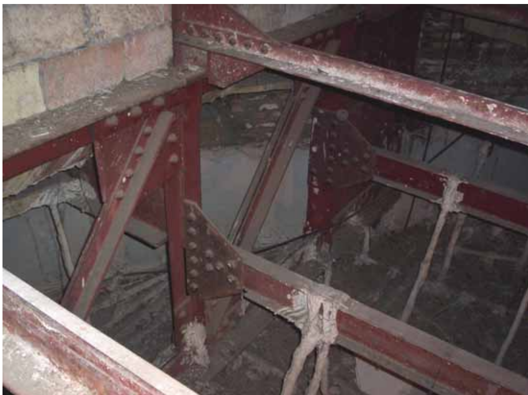
DETALLES DE UNIONES DE LA ESTRUCTURA METALICA
