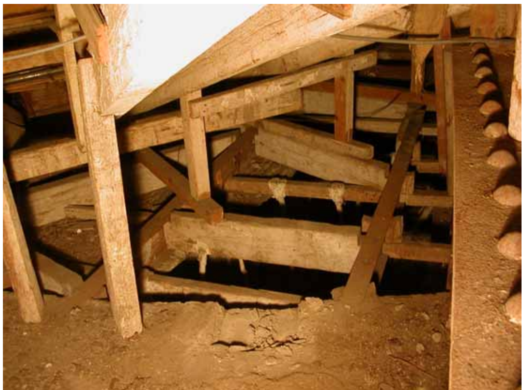
DETALLES DE UNIONES EN ESTRUCTURA AUXILIAR DE MADERA
